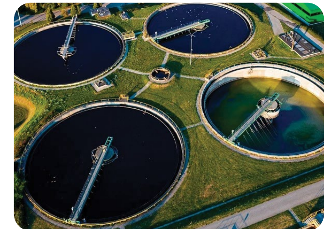
Hệ thống xử lý nước thải công nghiệp
